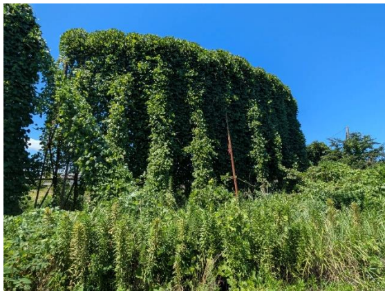
草に覆われたバックネット
